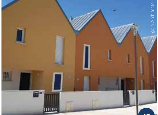
Résidence Nilüfer à Châlette-sur-Loing, agglomération montargoise, 6 maisons en location sociale
