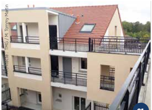
Les Noblets à St-Vrain, 25 appartements et 10 maisons en location sociale
