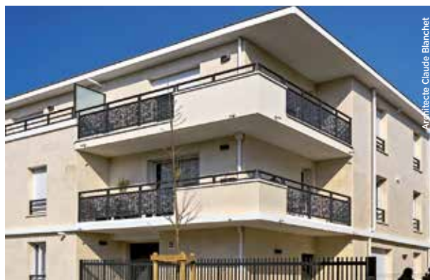
ECLAT DE LOIRE, ST-CYR-SUR-LOIRE - 37 Tours Métropole Val de Loire, 10 appartements
